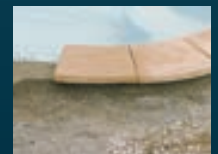
VERLEGEN DER RANDSTEINE
