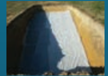
GEOTEXTILVERLEGUNG
